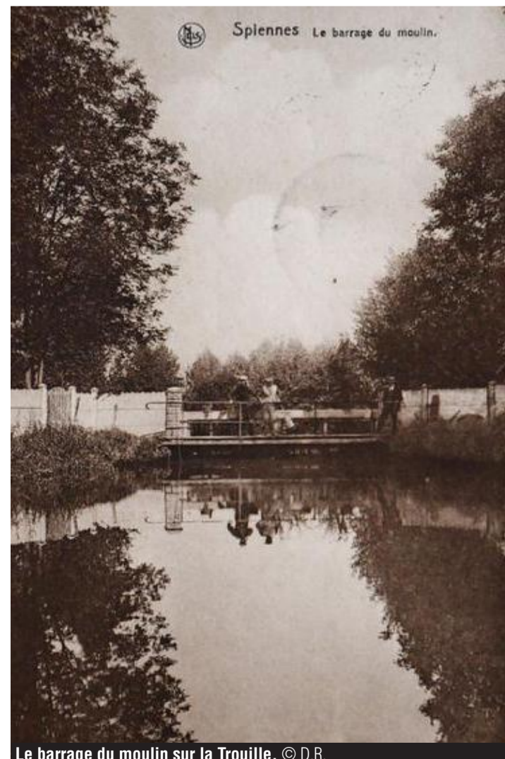
Le barrage du moulin sur la Trouille. © D.R.
